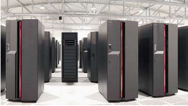
Höchstleistungsrechner des Forschungszentrums Jülich
