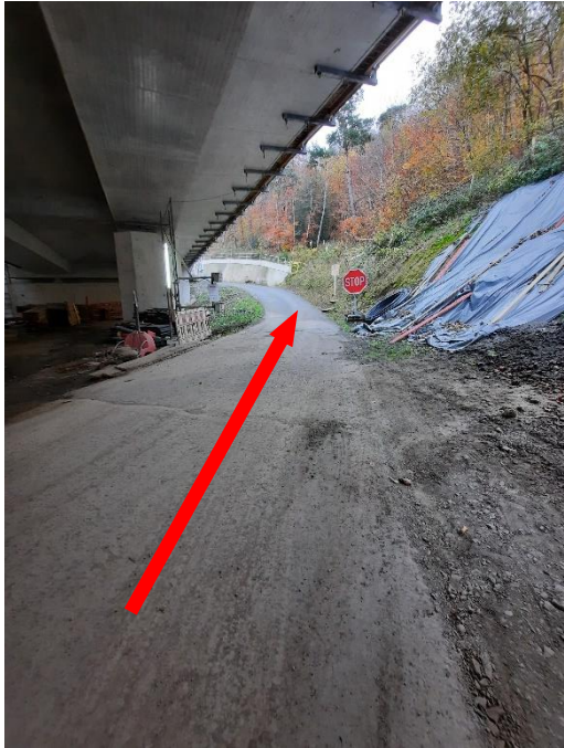
Baustellenausfahrt in FR Bremen
